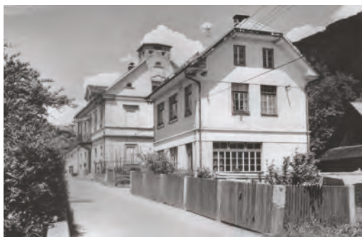
Stavba orožniške postaje v Križah z bunkerjem na strehi
