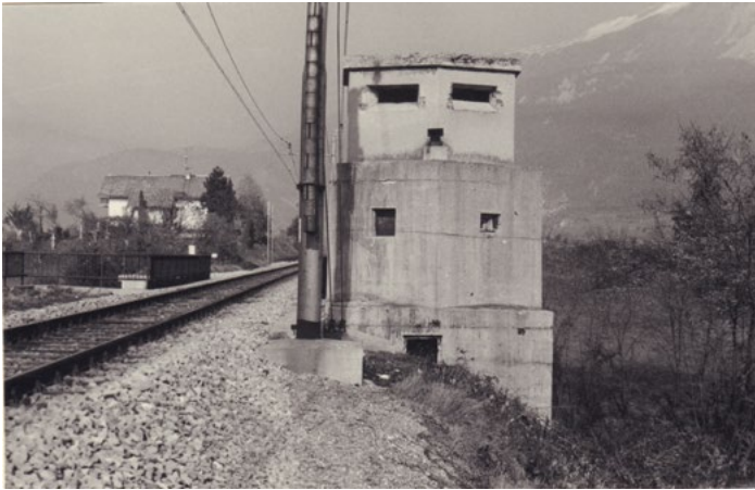
Bunker bei Vrba (Velden), an der Bahnlinie Ljublja- na - Jesenice
